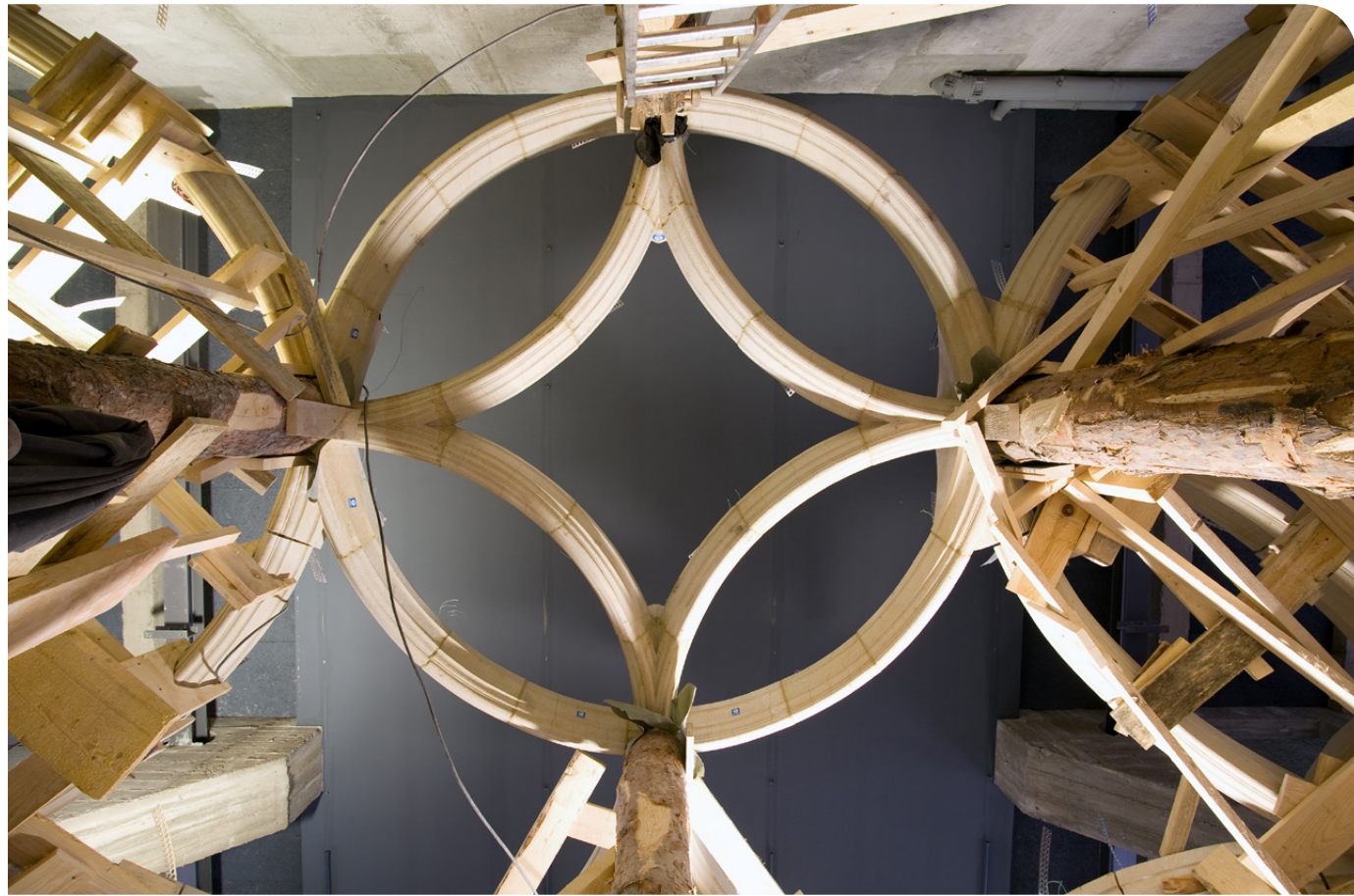
Rippenwerk in der Untersicht – Werksteinknoten wurden auf unbesäumten Baumstämmen versetzt
