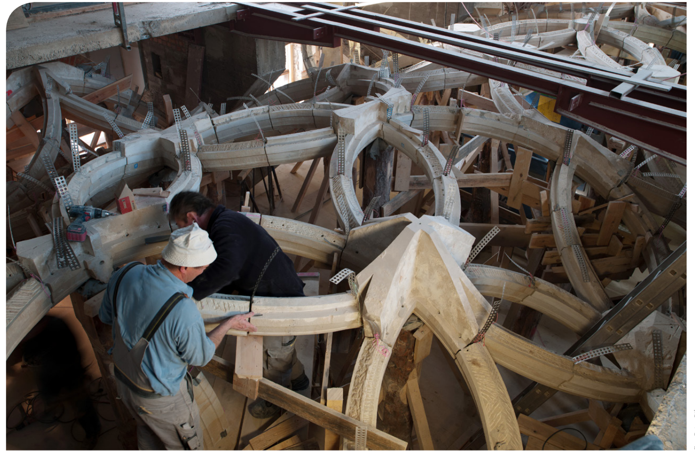
Versetzen der Werksteinrippen – Steffen Rau und Karsten Kramer von Dreßler Bau setzen ein Rippenwerkstück, mittels Ziehstiften verankert und später vergossen, in das Rippenwerk ein
