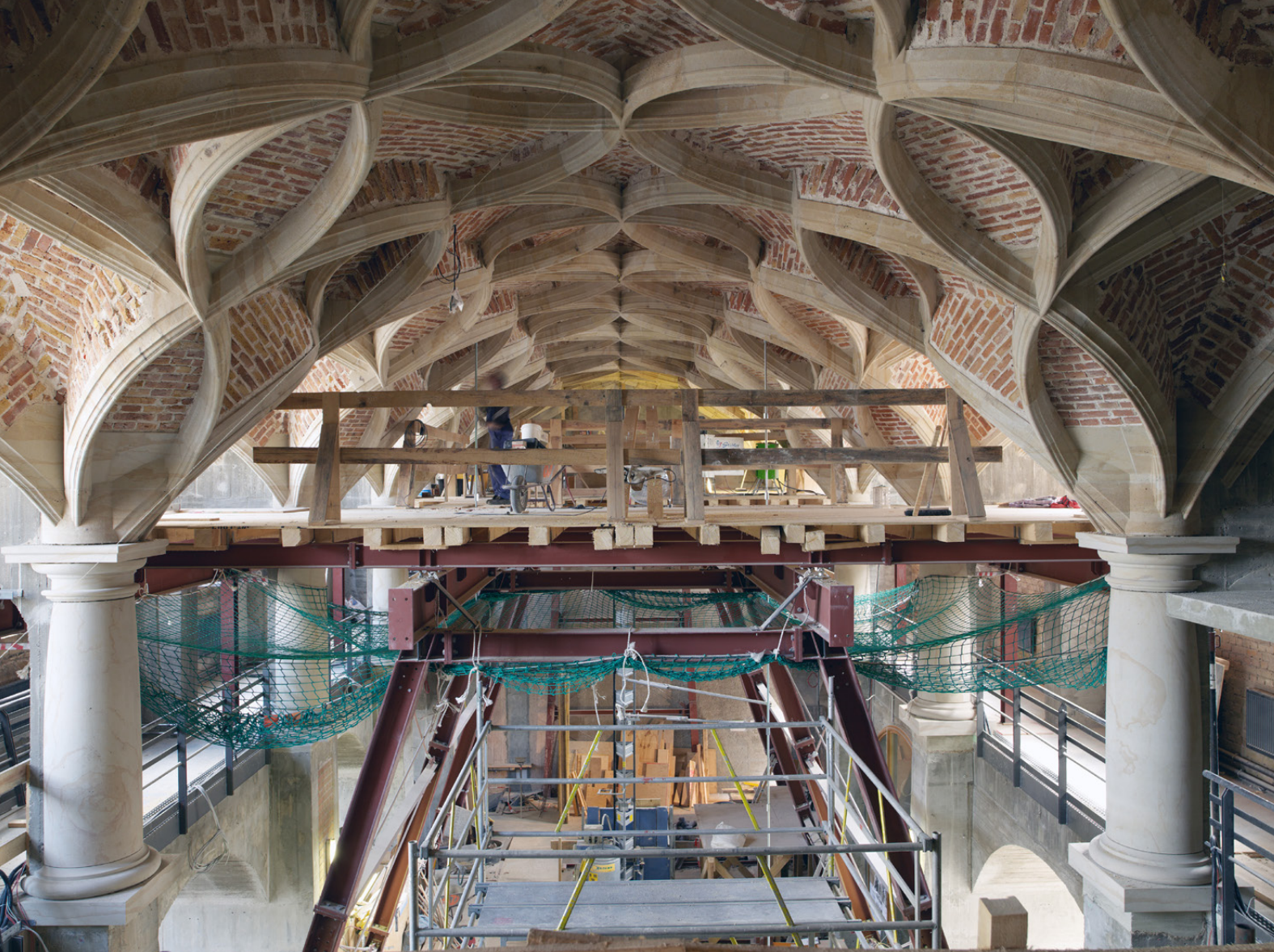
Gesamtansicht Schlingrippengewölbe zur Fertigstellung – Arbeitsboden aus Holzkonstruktion liegend auf einem Stahlrahmengerüst
