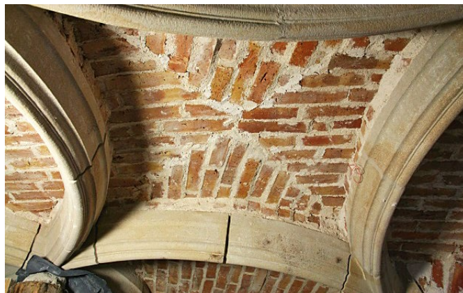
Bild 7. Mauerwerksverband in der Rautenfigur
