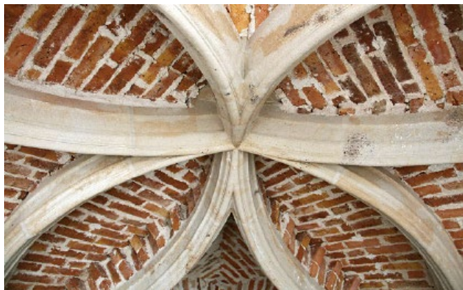
Bild 6. Mauerwerksverband in der Blütenblattfigur
