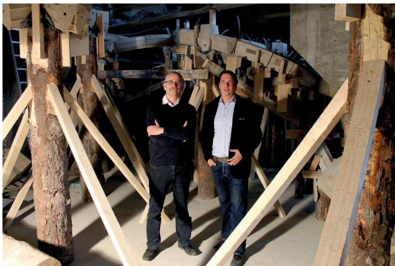
Bild: Thomas Bauer (re.) und Jörg Lauternach (li.) auf der Baustelle Rekonstruktion des Schlingrippengewölbes der Schlosskapelle im Schloss Dresden (Auftraggeber SIB Niederlassung Dresden 1, Leiter Ludwig Coulin)
