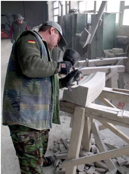
Bild 85 Ausarbeitung der Kehlungen mit beginnendem Randschlag und danach sphärisch gekrümmte Kehlfläche freihändig
