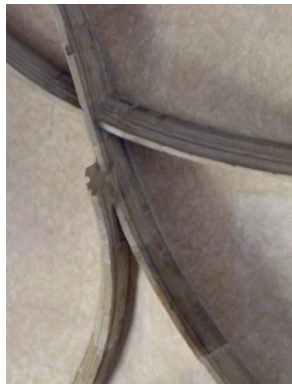
Bild 2.4.17 Wladislawsaal Prag, Rippe legt sich „schwebend“ an den Blütenstern an und endet dort
