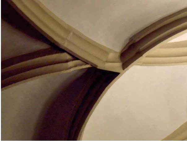
Bild 3.6.20 Bunzlau - Ratssaal, Passprobleme an Rippenkreuzungen werden offen ausgetragen und gezeigt
