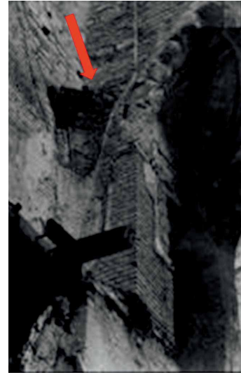
Bild 2.5.23 Gewölbeanfänger Ecke Kapellenraum Richtung Ap- sis
