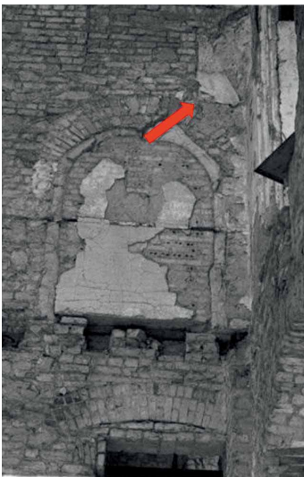
Bild 2.5.26 Ruinenfoto Erasmuskapelle – Emporenraum Gewölbeanfänger als rechteckiger Sandsteinblock (re.o.)
