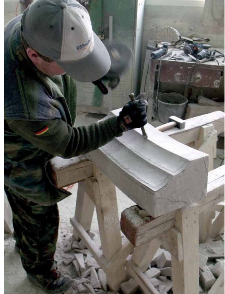
Bild 88 Ausarbeitung der Kehlungen mit beginnendem Randschlag und danach sphärisch gekrümmte Kehlfläche freihändig
