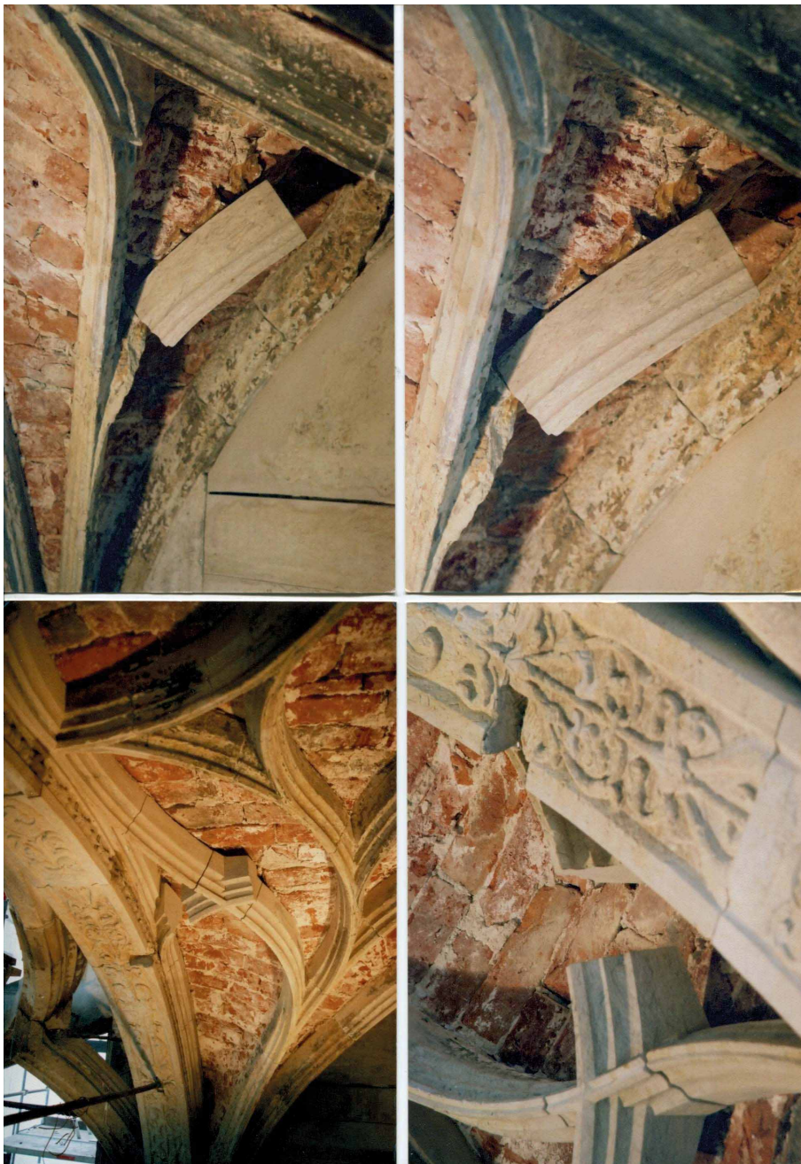
Bild 3.7.19 Wendelstein Schloss Hartenfels Torgau, Schlingrippengewölbe Konrad Krebs – Sanierung mit freiliegender MW-Wölbung
