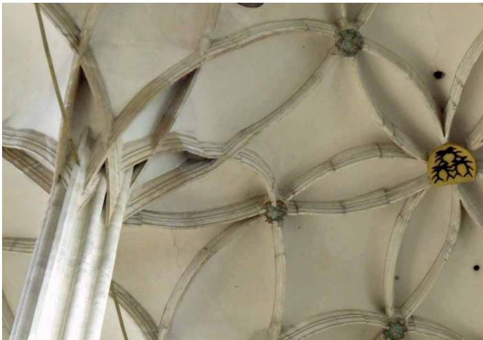
Bild 3.6.16 Kuttenberg, St. Barbara, erhebliche Passprobleme der Rippen werden ganz offen mit Ihrem im Detail unexakten Rippenverlauf gezeigt und fallen dem fachfremden Betrachter durch den räumlichen Gesamteindruck der gewundenen Rippenreihungen kaum auf
