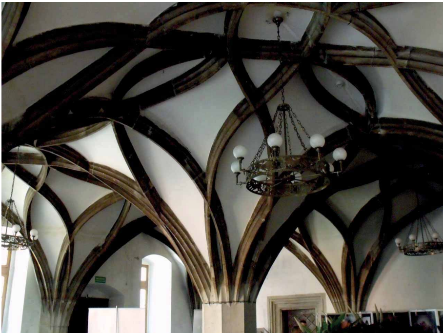
Bild 2.4.28 Schlingrippengewölbe Eingangshalle Rathaus Löwenberg mit zentralem achtteiligen Blütenstern und Gewölbekelchen
