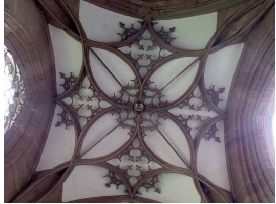
Bild 2.3.4 Rotbergjoch Gewölbeuntersicht – Schlingrippen mit hängendem Maß- und Stabwerk
