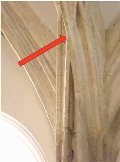
Bild 3.6.13 Wien Landhauskapelle, sich eigentlich symmetrisch kreuzende Rippen durchdringen sich nicht fluchtgerecht
