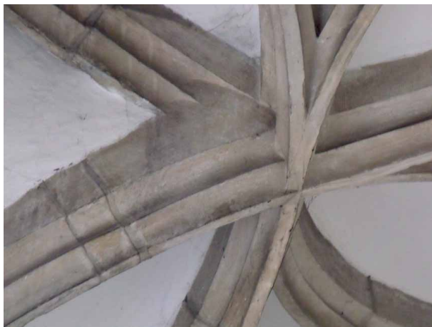
Bild 2.1.13 Knotenpunkte mit perfekter Passung und Krümmung, aber teilweise nicht voll durchgearbeitete Profildurchdringungen
