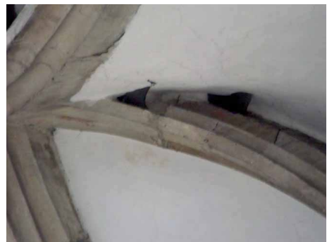
Bild 2.1.16 Knoten mit hinterschnitten einlaufenden Rippen und verdeckten Sandsteinstegen
