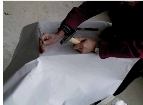
Bild 18 Reißen / Durchstechen Bogenaustragung mit Reißnadel
