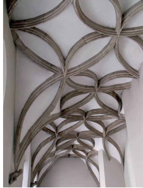
Bild 2.2.8 Schlingrippengewölbe Eleemosynariuskapelle Neusohl
