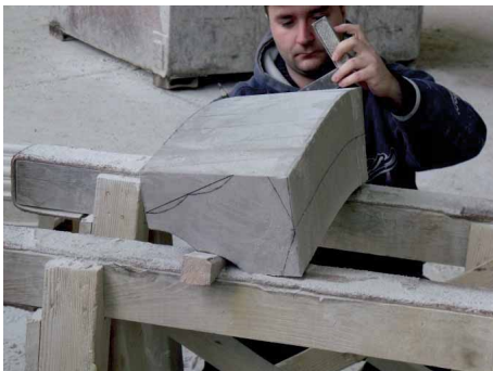
Bilder 95 und 96 nach Kehlung Innenseite Krümmung drehen und Kehllinien Außenseite auf Fugenfläche reißen und nach Abarbeiten der Schräge über der Kehlung dann die Kehlmittellinie längs der Rippe durch Reißziehle parallel zur unteren Mittellinie reißen
