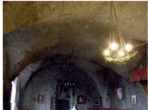
Bild 3.7.2 Sala Rycerska Gröditzburg – Wölbung trägt ohne Rippen
