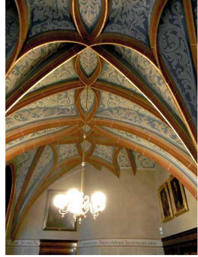
Bild 3.7.22 Sakristei St. Marien Pirna – die oben liegende und formgebende Rippenebene sind die Blütenblätter in Längs- und Querrichtung sowie alle Gurtruppen, die darunter liegende Ebene der Gratrippen (gebogen und gerade) haben Rippenaufmauerungen in Rippenstärke (gemeint ist Aufmauerung so breit wie die Rippe in der Untersicht breit ist)
