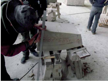
Bild 21 Reißen der zweiten Fugenfläche (Grundriss)
