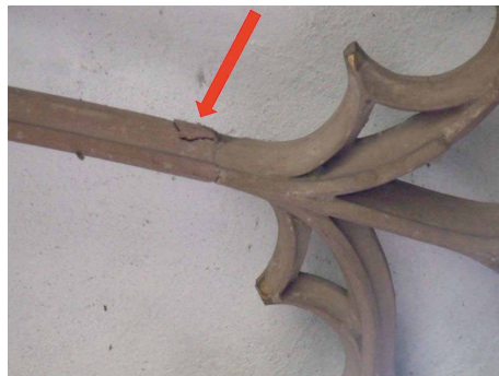
Bild 2.3.13 Hängender Stab mit Ausbruchsstelle am Maßwerkansatz
