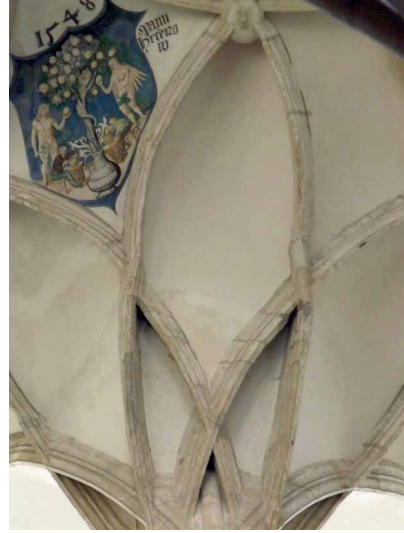
Bild 3.6.18 Kuttenberg, St. Barbara, erhebliche Passprobleme der Rippen, aber auch offenkundig nachträgliche Rekonstruktionen werden ganz offen mit Ihrem im Detail unexakten Rippenverlauf gezeigt
