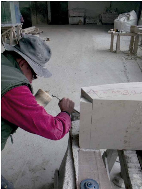
Bild 13 Abarbeiten erste Fugenfläche
