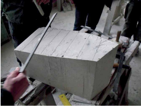
Bild 31 Prüfen (radiale Rechtwinkligkeit) Krümmung Unterseite
