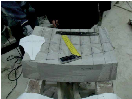
Bild 77 Reißen Fugenfläche im Aufriss
