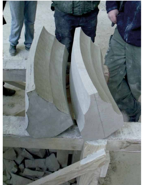
Bild 106 und 107 Vergleich beider Rippenwerkstücke – augenscheinlich außer Handschrift der Oberflächenbearbeitung keine Unterschiede
