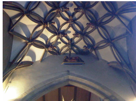
Bild 3.7.30 Marienkapelle mit Jesse- Rippenanschluss an Giebelwand
