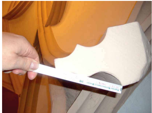
Bild 2.4.15 Rippenprofil Ratssaal Bunzlau, abgegriffen (Schablonen Abrieb vor Ort und nachgezeichnet) und vermessen am 02.04.2011 - nicht symmetrisch im Querschnitt sowie differente Höhen der Kehlsätze
