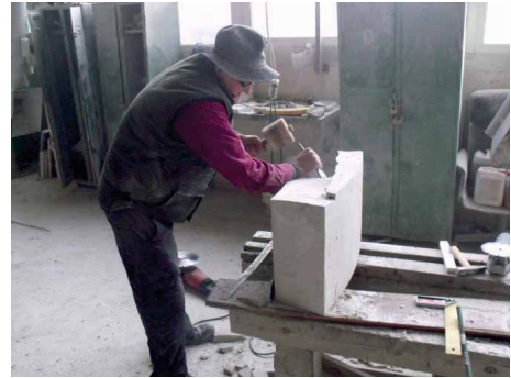
Bild 26 Abarbeiten Krümmung Unterseite
