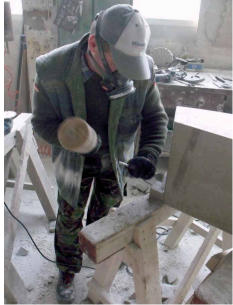
Bild 62 nach erster Krümmung auf der Rippenaußenseite wird die erste Fugenfläche abgearbeitet
