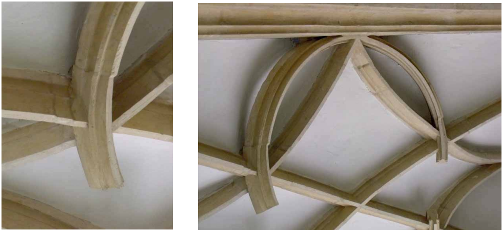
Bild 3.6.15 Brüx, Mariä Himmelfahrt, Abweichung zwischen den Radien der oberen Halbkreisfigur und den überschnitten die übrigen Rippen kreuzenden Bogenenden wurden durch Versatz an der Fuge aufgenommen
