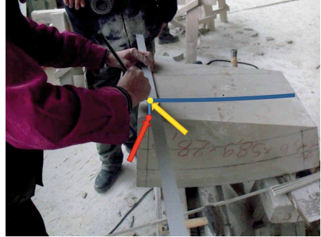
Bild 22 Reißen der zweiten Fugenfläche (Aufriss) – hier Fehler zu sehen, da radial ausgerichtete Fuge im Aufriss die im Grundriss angerissene lotrechte „obere Fuge“ nicht auf Stein- oberseite schneiden muss (roter Pfeil), sondern auf der gekrümmten Kurve der oberen Wangen (grau) schneiden soll (gelber Pfeil). Ist später korrigiert wurden (Fehler sind Quelle der Erkenntnis)
