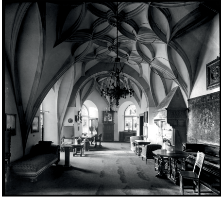
Bild 3.7.24 Erasmuskapelle Berlin Kapellenraum – Rippenerrhöhungen im Rippenwerk durch oberseitige Werksteinerhöhung an die Wölbenebene, womit eine innovative Lösung gefunden ist, da Verformungen der Wölbung direkt über den Werkstein verlaufen
