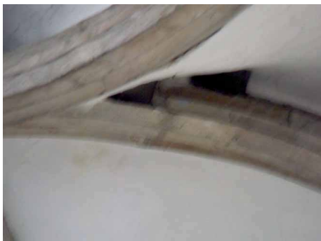
Bild 2.1.16 Knoten mit hinterschnitten einlaufenden Rippen und verdeckten Sandsteinstegen
