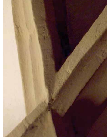
Bild 3.6.20 Bunzlau - Ratssaal, Passprobleme an Rippenkreuzungen werden offen ausgetragen und gezeigt
