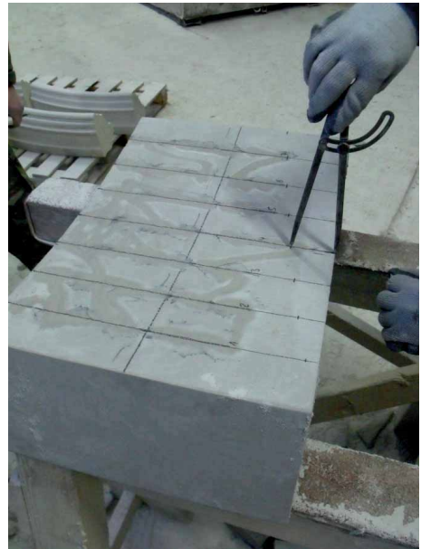
Bild 74 Abgreifen des Lotes zwischen Basislinie und Bogenaustragung und Übertragen auf gleiche Teilung auf dem Krümmung
