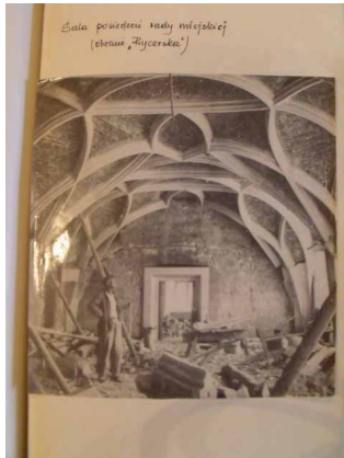
Bild 2.4.34 Rathaus Löwenberg Ratssitzungssaal – Aufnahme nach Schädigung 1945 mit freiliegendem Mauerwerksverband
