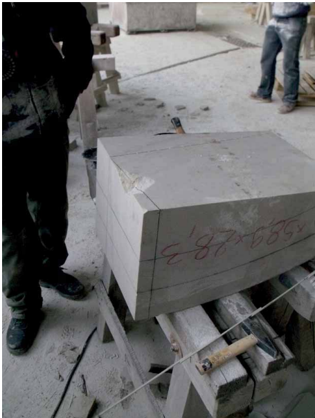
Bild 23 Reißen der zweiten Fugenfläche
