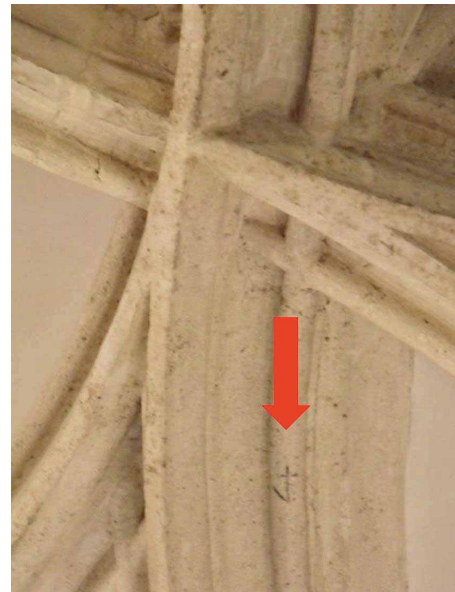
Bild 2.2.6 Steinmetzzeichen in der Kapelle Wien (ist das in Wiener Kapelle am häufigsten auftretende Zeichen, wir haben es 5 mal gesehen)
