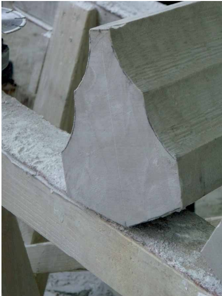
Bild 106 und 107 Vergleich beider Rippenwerkstücke – augenscheinlich außer Handschrift der Oberflächenbearbeitung keine Unterschiede
