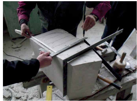
Bild 30 Prüfen (radiale Rechtwinkligkeit) Krümmung Unterseite
