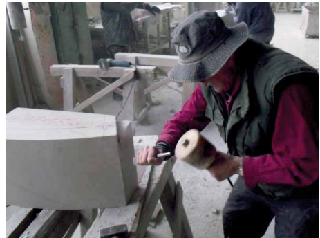
Bild 12 Abarbeiten erste Fugenfläche
