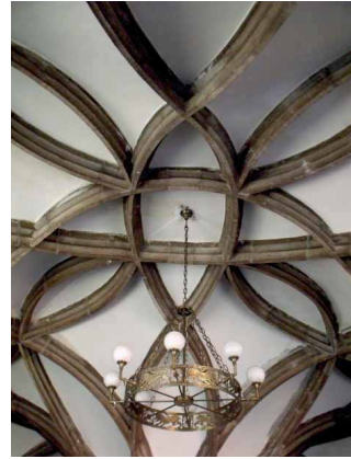
Bild 2.4.27 Eingangshalle Rathaus Löwenberg – Details des Rippenwerkes der Schlingrippenfiguration
