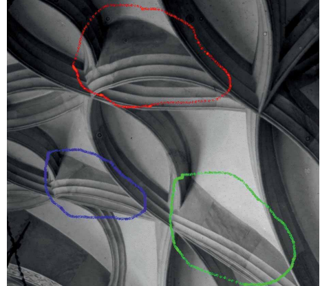
Bild 3.7.24 Erasmuskapelle Berlin Kapellenraum – Rippenerrhöhungen im Rippenwerk durch oberseitige Werksteinerhöhung an die Wölbenebene, womit eine innovative Lösung gefunden ist, da Verformungen der Wölbung direkt über den Werkstein verlaufen
