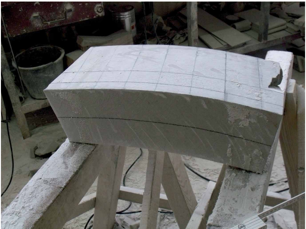
Bild 99 Abarbeiten der Schräge über aus dem Krümmling für Anreißen der Kehlmittellinie auf der Außenseite der Rippe, danach Fertigstellung Rippenkörper durch freihändiges Ausarbeiten der sphärisch gekrümmten Kehlflächen
