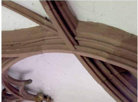
Bild 2.3.15 Perfekte ausgearbeitete Profildurchdringung an der Rippenkreuzung
