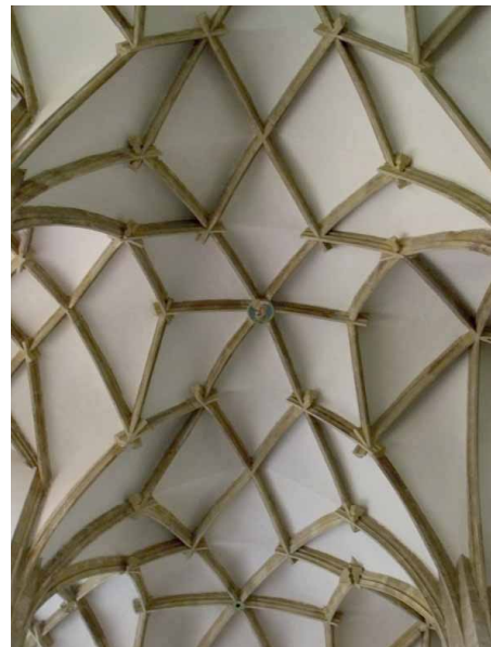
Bild 3.1.2 Netzwerkgewölbe Pfarrkirche Mariä Himmelfahrt Brüg Seitenschiff Ost
