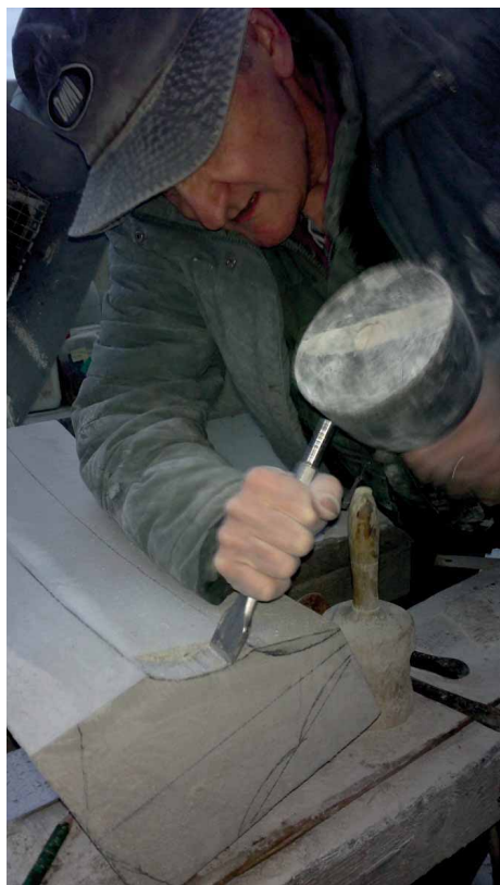
Bild 47 Randschlag zum Ausarbeiten der Kehlung
