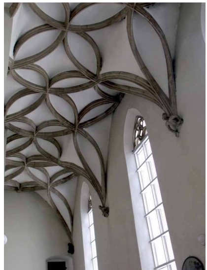
Bild 2.1.9 Nordwand – Blickrichtung West
