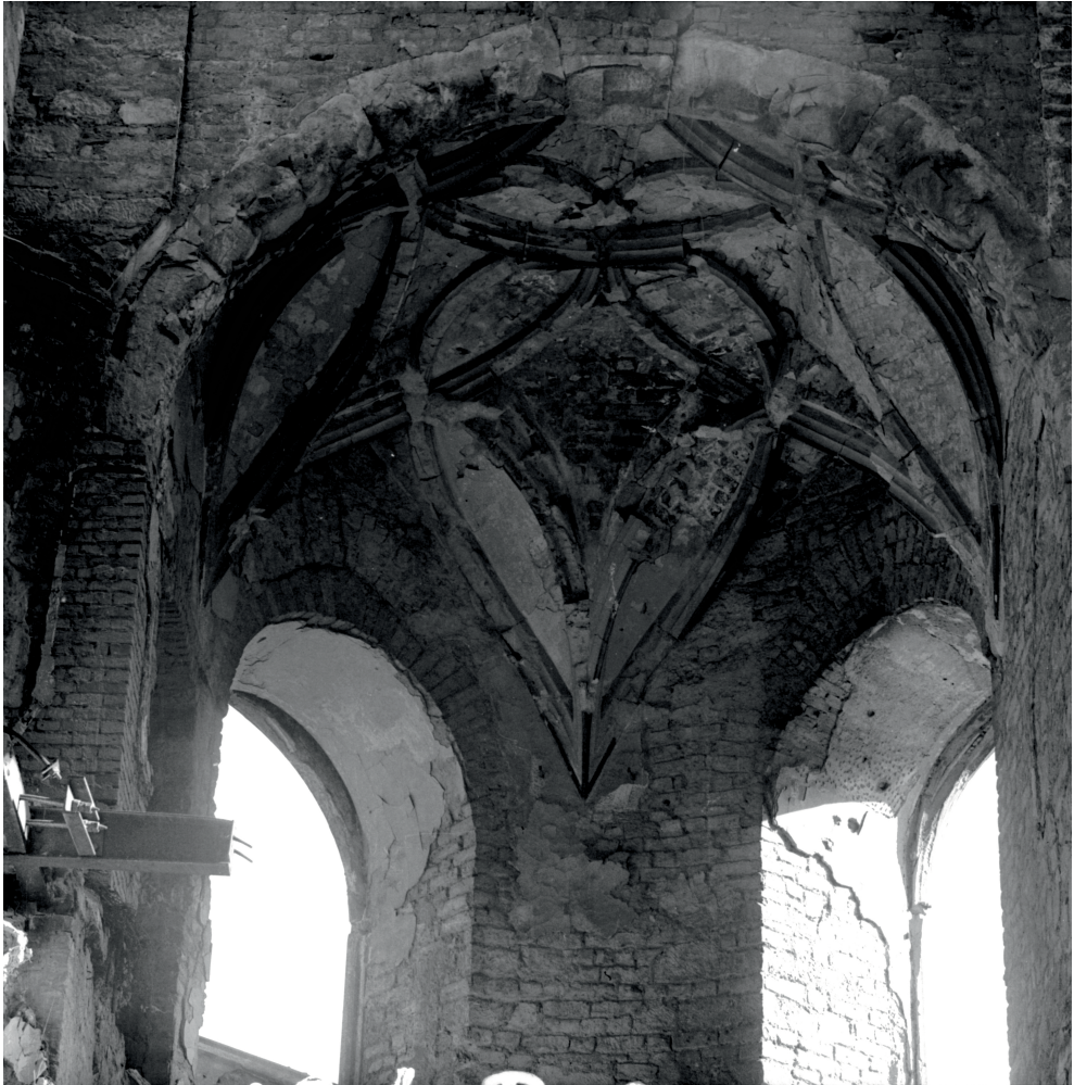
Bild 2.5.24 Ruinenfoto Erasmuskapelle – Apsis (Aufnahme 1951) mit gut erkennbaren Mauerwerksverbänden
