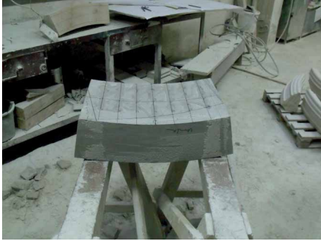
Bild 79 Reißen Fugenfläche im Aufriss
