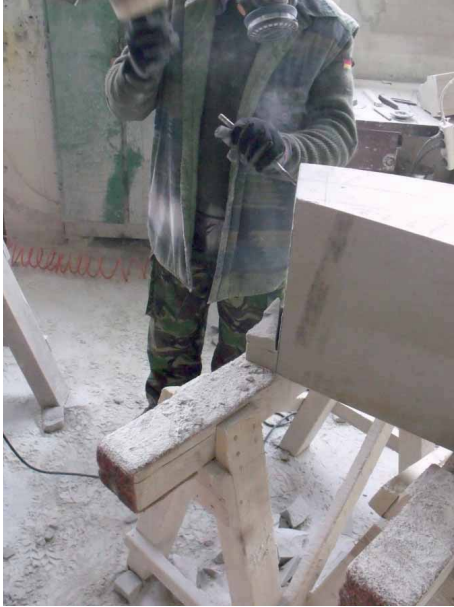
Bild 61 nach erster Krümmung auf der Rippenaußenseite wird die erste Fugenfläche abgearbeitet
