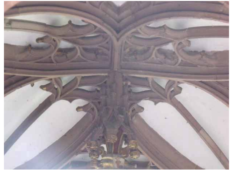
Bild 2.3.19 sehr flach verlaufender Zentralbereich des Rippenwerkes (fast waagrecht)
