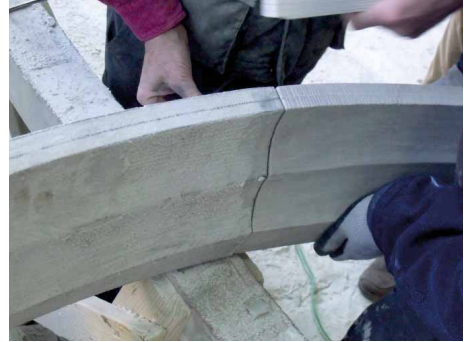
Bilder 100 und 101 Vergleich Krümmung und Oberflächen durch Aneinanderhalten beider Rippenwerkstücke
