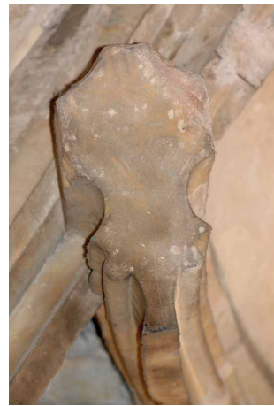
Bild 3.5.18 Wladislawsaal Prag – Profilschablonen mit Rissmittellinien und erkennbaren Differenzen in Profilsymmetrie (z.B. Bild 3.5.16 vorletzter Profilschnitt, am unteren Profilsteg Außer-mittigkeit und Assymetrie untere Kehlung)
