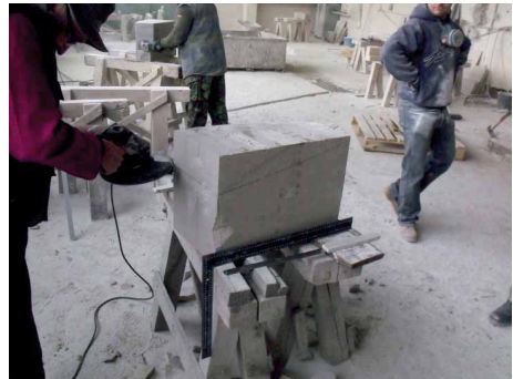
Bild 24 Abarbeiten Krümmung Unterseite
