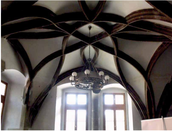
Bild 2.4.27 Eingangshalle Rathaus Löwenberg – Details des Rippenwerkes der Schlingrippenfiguration
