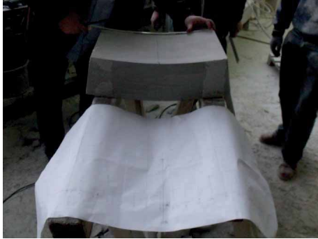
Bild 71 Unterteilen des Krümmings in 8 gleiche Teile auf dem Innenradius (ausgehend aus Teilung Unterseite)
