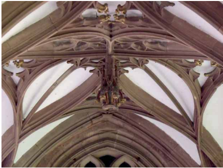
Bild 2.3.18 sehr flach verlaufender Zentralbereich des Rippenwerkes (fast waagrecht)
