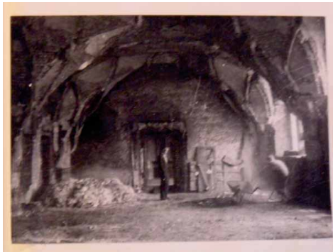
Bild 3.7.1 Ratssaal Löwenberg – Wölbung trägt auch ohne Rippen
