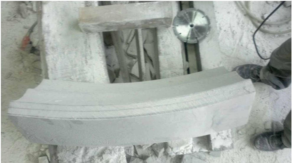
Bild 50 nach Fertigstellung der Schräge über innerer Kehlung kommt das Reißen der mittleren Kehllinie auf der Außenseite der Rippe
