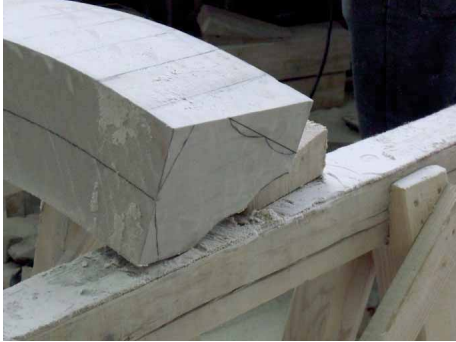
Bilder 97 und 98 Reißen der Kehlen Außenseite
