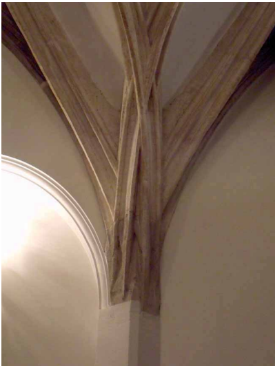
Bild 3.6.9 Wien-Landhauskapelle, Rippenanfänger links liegt Messbar höher als Rippenanfänger rechts
