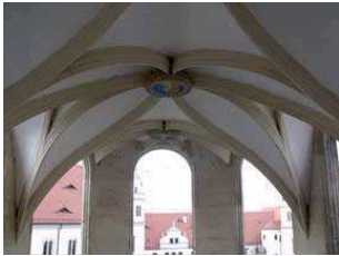
Bild 2.5.14 Schlingrippengewölbe K.Krebs, Wendelstein Schloss Hartenfels Torgau
