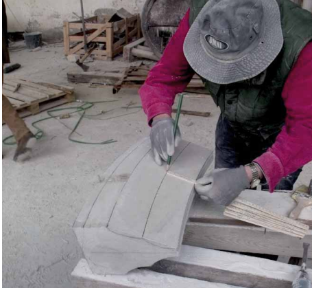
Bild 51 Reißen der mittleren Kehllinie auf Außenseite Rippe
