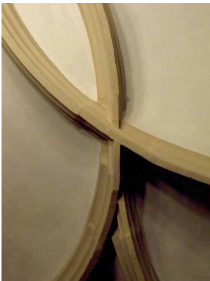
Bild 2.4.16 Ratssaal Bunzlau, Rippe bindet optisch und handwerklich in grober Detaillösung in Blütenstern ein
