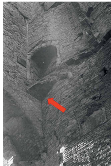
Bild 2.5.27 Ruinenfoto Erasmuskapelle Kapellenraum am Grünen Hut mit erkennbarer Anlage der Wölbung in Raumecke
