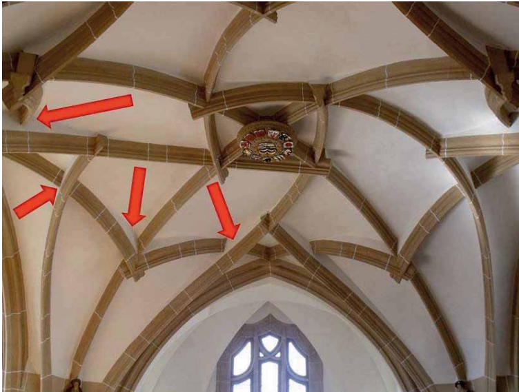
Bild 3.7.23 Wappensaal Burg Meißen – hier sehr gut zu sehen wie formgebenden Rippen von den darunter verlaufenden Rippen höhenmäßig unterlaufen werden und zwischen tieferer Rippenebene und Wölbenebene eine Aufmauerung in Rippenbreite augenscheinlich vorgenommen wurde
