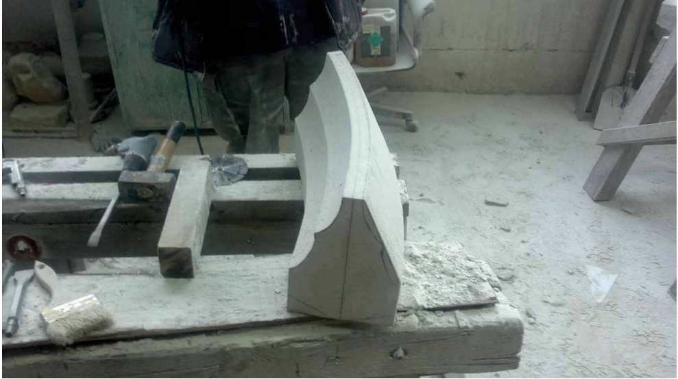
Bild 49 nach Fertigstellung der Schräge über innerer Kehlung kommt das Reißen der mittleren Kehllinie auf der Außenseite der Rippe
