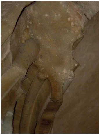
Bild 3.5.18 Wladislawsaal Prag – Profilschablonen mit Rissmittellinien und erkennbaren Differenzen in Profilsymmetrie (z.B. Bild 3.5.16 vorletzter Profilschnitt, am unteren Profilsteg Außer-mittigkeit und Assymetrie untere Kehlung)
