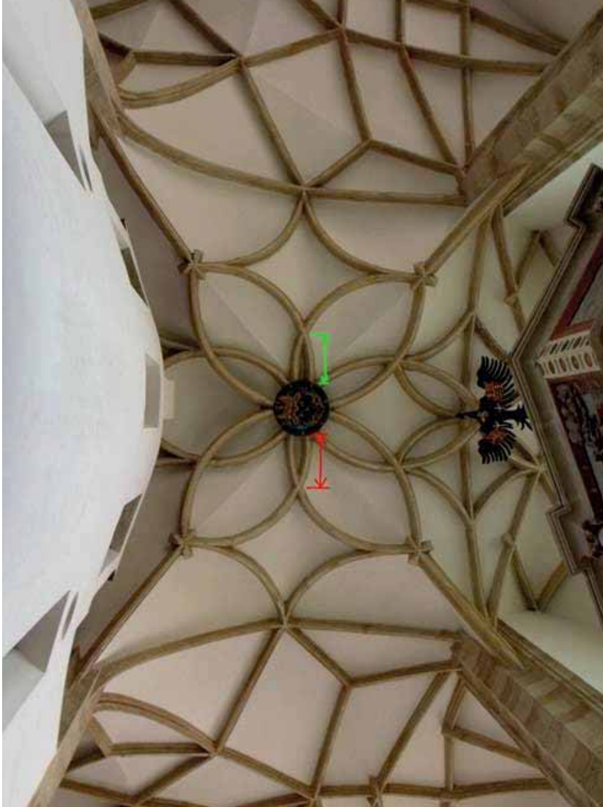
Bild 3.6.2 Brügge, Pfarrkirche Mariä Himmelfahrt, Chorbereich, Toleranzen der Jochdimensionen werden bei dem mittig angeordneten Schleifenstern durch differente Überschneidungen der Schleifen aufgenommen. Links (rot markiert) überschneiden die Rippe mehr als an der identischen Figur rechts (grün markiert)
