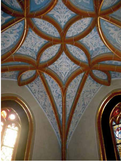
Bild 3.7.22 Sakristei St. Marien Pirna – die oben liegende und formgebende Rippenebene sind die Blütenblätter in Längs- und Querrichtung sowie alle Gurtruppen, die darunter liegende Ebene der Gratrippen (gebogen und gerade) haben Rippenaufmauerungen in Rippenstärke (gemeint ist Aufmauerung so breit wie die Rippe in der Untersicht breit ist)
