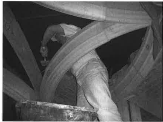
Abb. 11: Standfläche Maurer zur freien Wölbung – außer im Scheitelbereich, wo von oben gemauert wird (Foto: bauer lauterbach Archiv).
