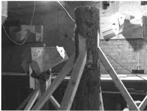
Abb. 8: Schritt 1, Versatz Rippenknoten auf Baumstämmen sowie in Wandauflagern die so mit Ihren Rippenausläufen den Rippenverlauf zum Versatz definieren (Foto: bauer lauterbach Archiv).
