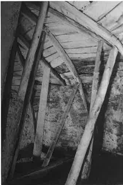
Abb. 4: Lehrschalung um 1350 Pfarrkirche Lärbro/Gotland mit sichtbarer Mörtelausgleichsschicht in einem Feld. (Foto aus Christian Mai , Die Lehrgerüste spätgotischer Zellengewölbe in zeitgenössischen Schriftquellen, aus dem Tagungsband „Traces of Making“, S. 159).
