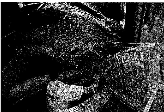
Bild 24: Freies Wölben über dem Rippenwerk als Geometrievorgabe (Abb.: R. Böhme)
