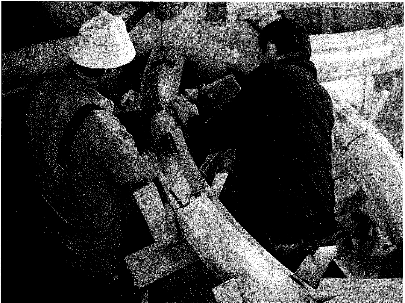
Bild 23: Versatz von Rippenwerkstücken zwischen den Knoten (Abb.: R. Böhme)
