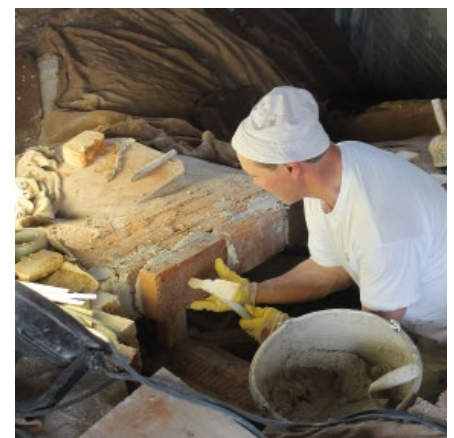
Bild 4. Ansetzen eines Wölbziegels an den zuvor gemauerten Wölbsegelebogen in Freier Wölbung
