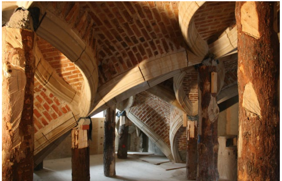
Bild 1. Rekonstruktion des Schlingrippengewölbes der Schlosskapelle Dresden – hier noch mit Unterstützungen des Rippenwerkes mittels unbesäumten Baumstämmen (Foto: Gert Schubert)
