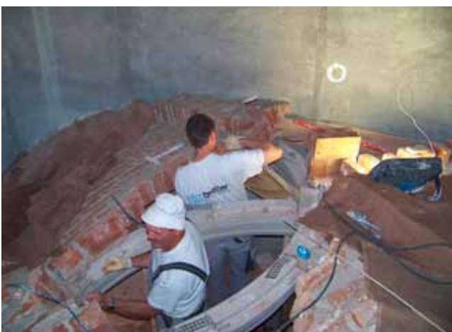
Abb. 51: Freies Wölben (re.+li. Juteabdeckung zum Feuchthalten)
