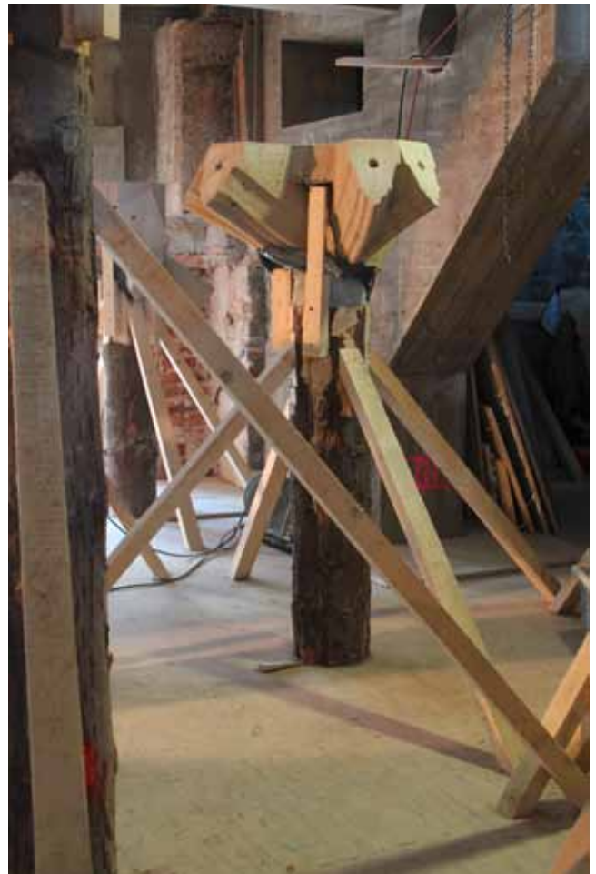
Abb. 24 und 25: Knotenversatz auf Baumstämmen über Zwickelstempel, danach Vermörtelung (Knoten-Stamm) zum Lastabtrag (historisch wahrscheinlich über Kirschkernkissen oder Sandsäcke)
