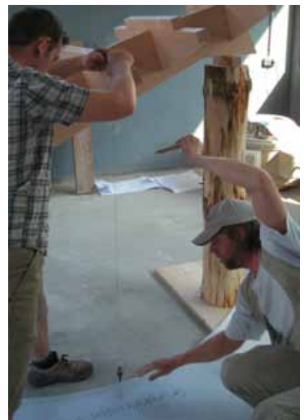
Abb. 2 und 3: Modell 2 – Biege zwischen Knotenpunkten mit Verlauf Prinzipalbogen für Orthogonalprojektion und Schiebelehren sowie Abgreifen des Grundrissradius des Kurvenverlaufes über Falllot
