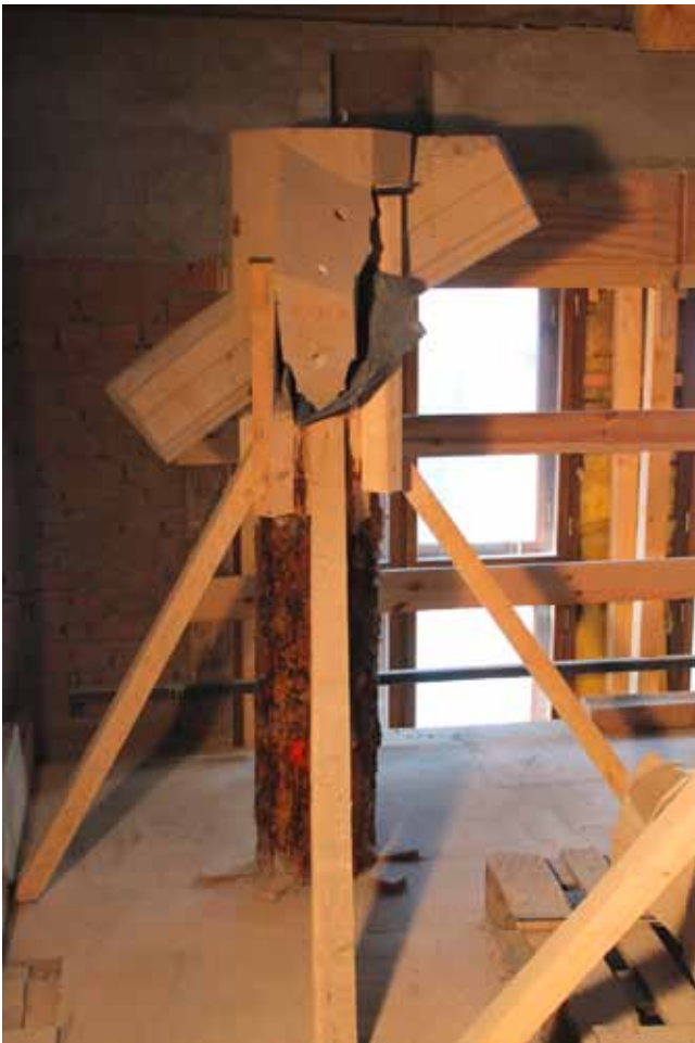
Abb. 24 und 25: Knotenversatz auf Baumstämmen über Zwickelstempel, danach Vermörtelung (Knoten-Stamm) zum Lastabtrag (historisch wahrscheinlich über Kirschkernkissen oder Sandsäcke)
