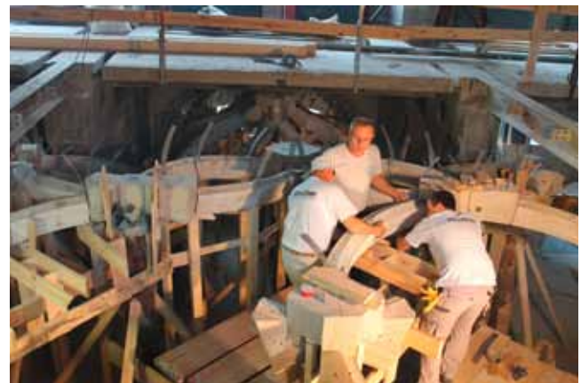
Abb. 31: Setzen der zweiten Rippe zwischen zwei Knoten
