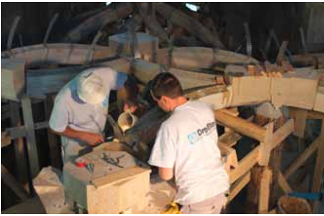
Abb. 32: Verguss der Rippenfuge über Gusskanäle im Werkstein
