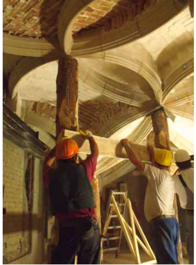
Abb. 36: Rückbau der Schubaussteifungen
