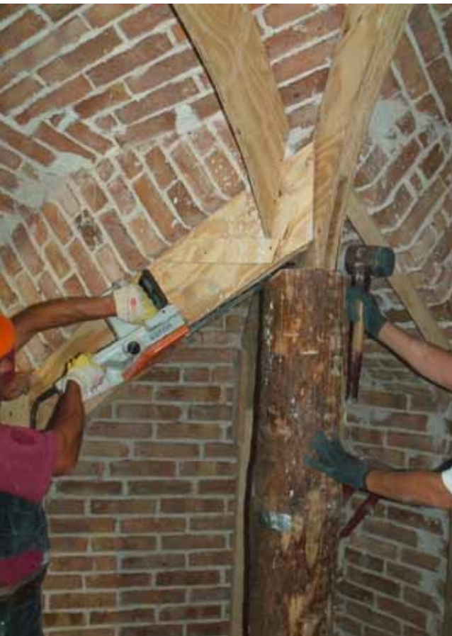
Abb. 35: Schrägschnitte am Stammkopf zur Lockerung
