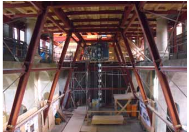
Abb. 47: Arbeitsboden (Untersicht) auf Stahlrahmengerüst
