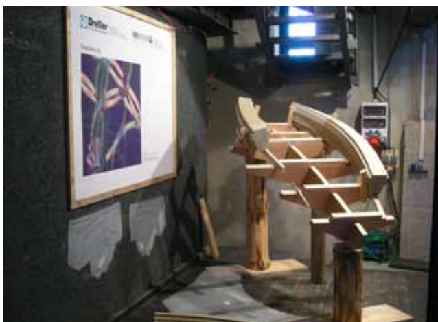
Abb. 6 und 7 Modell 2 - Versatz der Rippen über Schiebelehren
