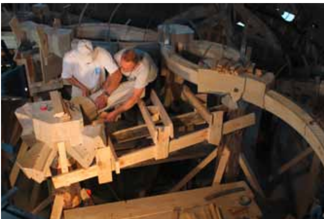
Abb. 30: Setzen der ersten Rippe zwischen zwei Knoten
