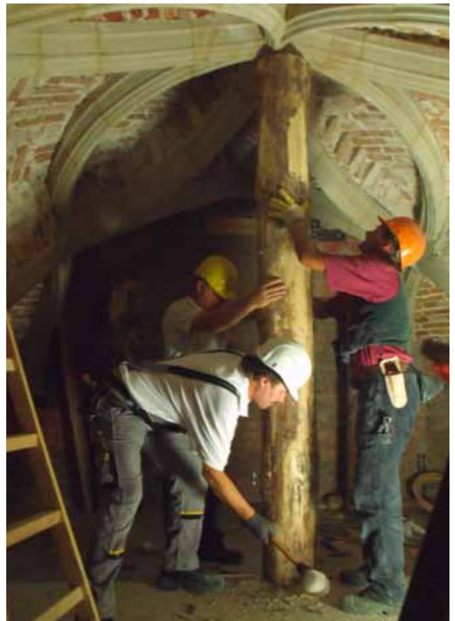
Abb. 37: Ausschlagen der Baumstämme am Fuß
