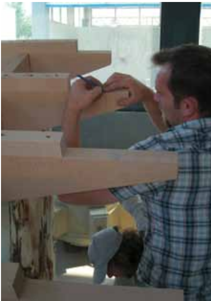
Abb. 4: Modell 2 - Anreißen des über Falllot abgegriffenen Schnittpunktes Grundrissradius und Bogenaustragung der Biege auf den Schiebelehren und Versatz Rippe
