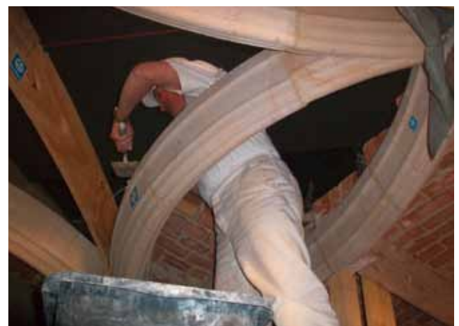
Abb. 52: Freies Wölben über Rippenwerk; Standfläche Maurer
