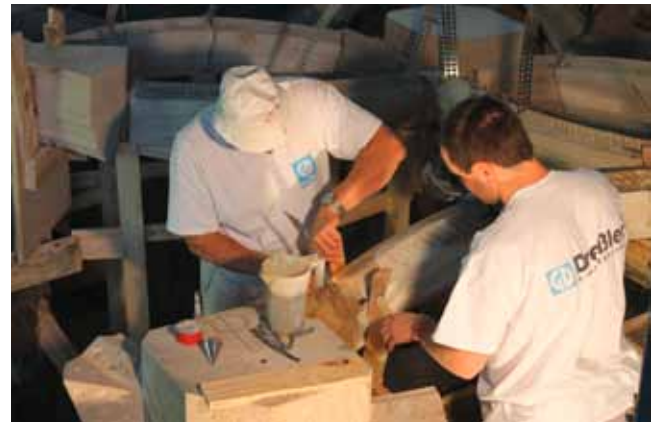
Abb. 33: Verdämmung der Rippenfuge mit Hanf
