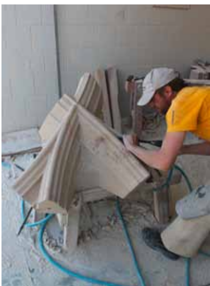
Abb. 44 und 45: Völlig freihändige Ausarbeitung der Rippenprofilkörper am Knoten nach vorherigem Steinschnitt nach 3D-Schablone, hier zu sehen ist die Knotenfertigung mit den Steinmetzen Jens Schrot und Jens Wildenhayn von Fuchs & Girke in Ottendorf-Okrilla
