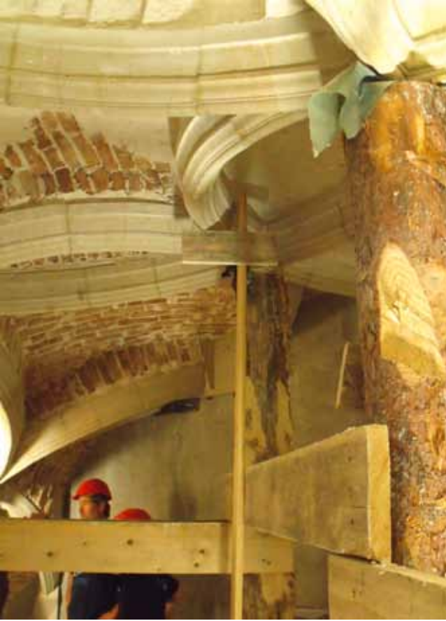
Abb. 34: Holzbrett unter Rippe zur Kontrolle der Verformung
