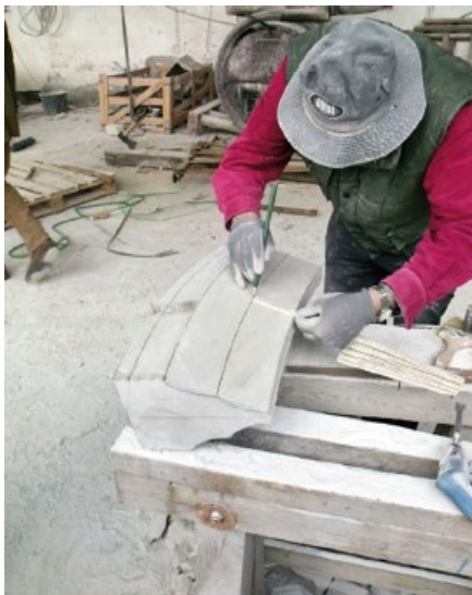
Bild 26. Fertigung Rippe nach Orthogonalprojektion Fig. 26. Rib production according to orthogonal projection
