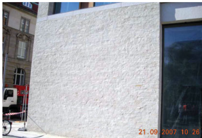
Bild 32. Mittlere Sicht Galerie Hinter dem Gießhaus Berlin Fig. 32. Medium-distance view of gallery behind the Giesshaus Berlin
