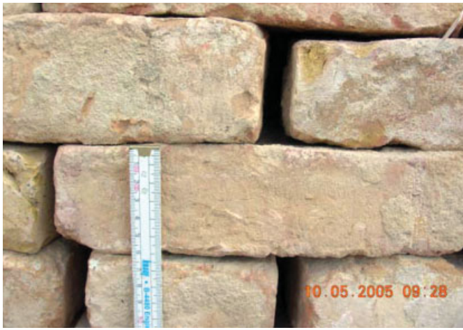
Bild 9. Maßtoleranzen historischer Handstrichziegel Fig. 9. Dimensional tolerances of historic handmade bricks
