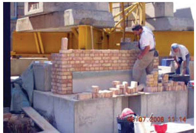
Bild 21. Musterwand Hinter dem Gießhaus Berlin Fig. 21. Sample wall behind the Giesshaus Berlin
