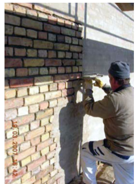
Bild 29. Aufziehen des Schlämmörtels Fig. 29. Application of the slurry mortar
