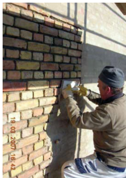
Bild 28. Aufziehen des Schlämmörtels Fig. 28. Application of the slurry mortar
