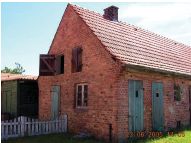
Bild 7. Untersuchtetes Rückbauobjekt Fig. 7. Examined back-construction property
