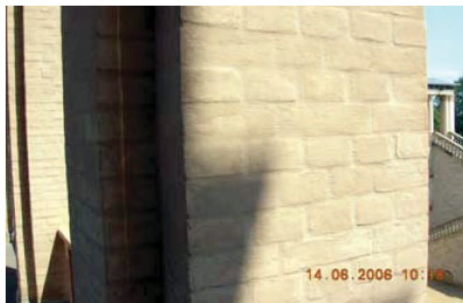
Bild 15. Nahsicht Belvedere Potsdam Fig. 15. Close-up view of Belvedere Potsdam
