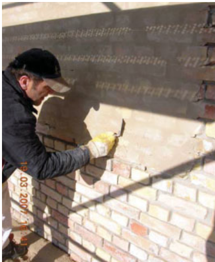
Bild 30. Kratztechnik Fig. 30. Scraping technique
