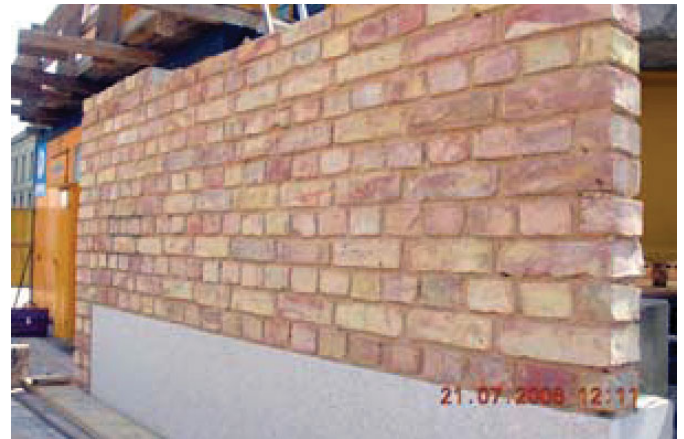
Bild 23. Muster Fugenmörtel Hinter dem Gießhaus Berlin Fig. 23. Jointing mortar samples behind the Giesshaus Berlin
