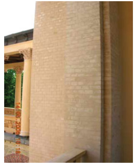
Bild 16. Nahsicht Belvedere Potsdam Fig. 16. Close-up view of Belvedere Potsdam
