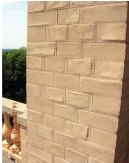
Bild 14. Nahsicht Belvedere Potsdam Fig. 14. Close-up view of Belvedere Potsdam
