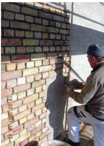
Bild 27. Aufziehen des Schlämmörtels Fig. 27. Application of the slurry mortar
