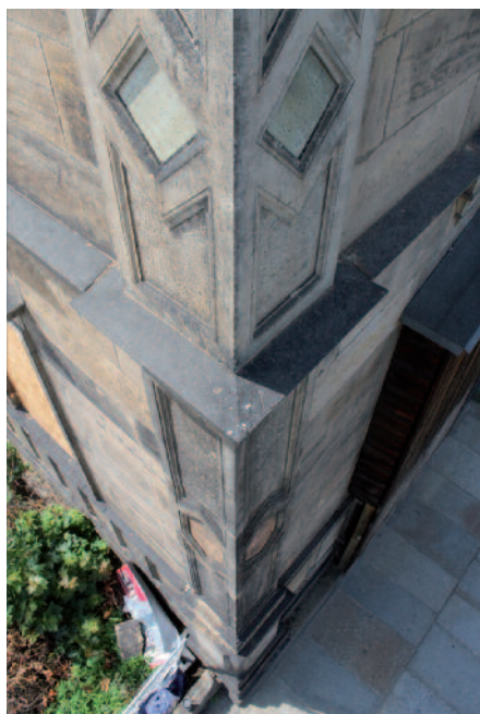
Abb. 5: Inkrustationen am Eckpilaster in Rauten- (grün) und Rhombenform (rot). (Foto: bauer lauterbach)
